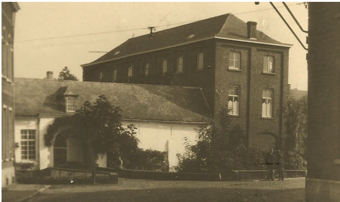
Figuur 9: zicht op poortgebouw en later bijgebouwde oostelijke vleugel (rechts) – foto dienst wonen & bouwen Ronse
