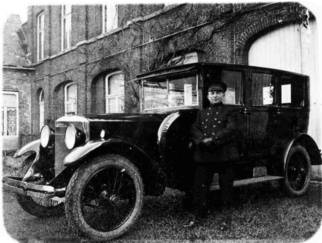
Figuur 11: zicht op gevel binnenkoer oostvleugel (voor 1940) – dienst wonen en bouwen Ronse
