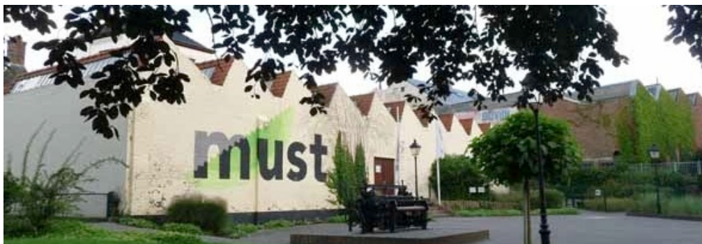
Figuur 12: zicht op westgevel van mechanische weverij (heden).
