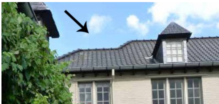
Figuur 52: knik in dak, andere uitvoering dan op plannen uit 1940-1942.
