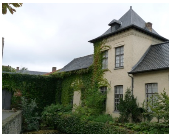
Figuur 66: zicht op verbouwde deel links van toren (heden)
