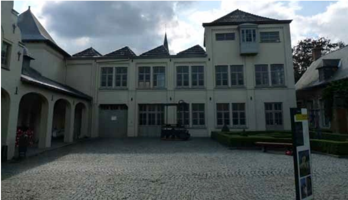
Figuur 33: foto oostgevel aanbouw aan westlijke vleugel (heden).
