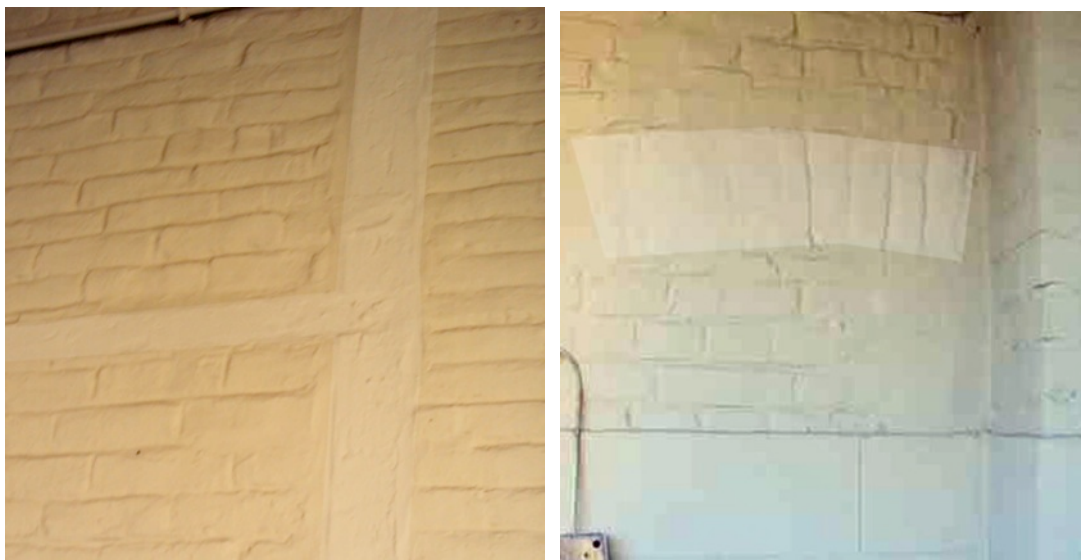
Figuur 74 en Figuur 75: : vermoedelijk sporen van vakwerk en spoor van rollaag
