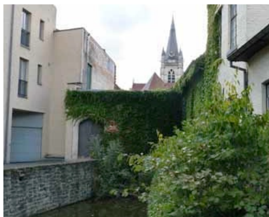
Figuur 67: zicht op verbouwing blinde gevel fabriek, het venster zit achter het groen verborgen (heden)
