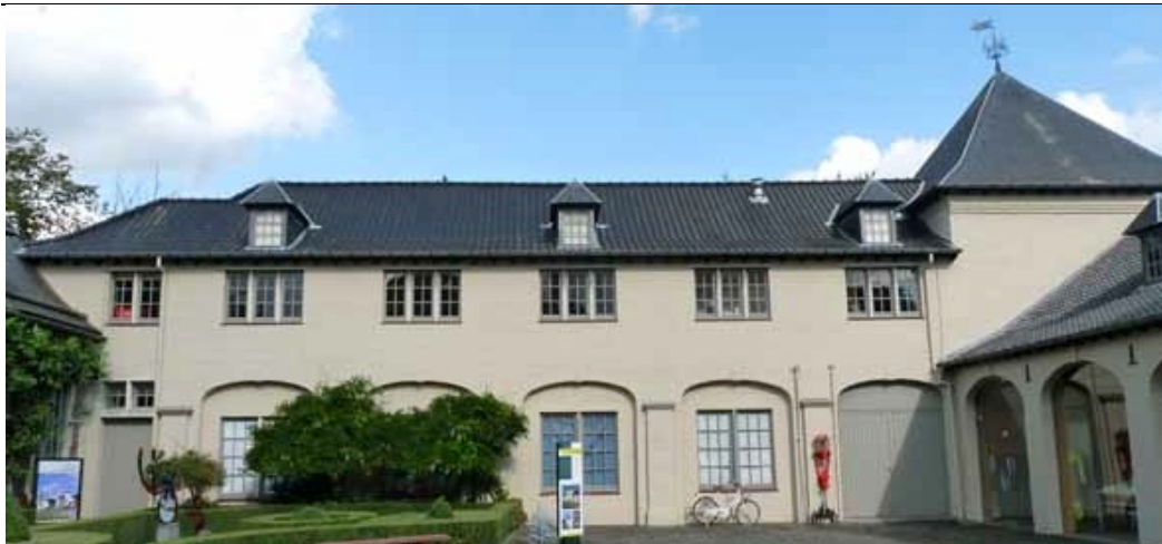
Figuur 3: zicht op gevel binnenkoer van de oostvleugel
