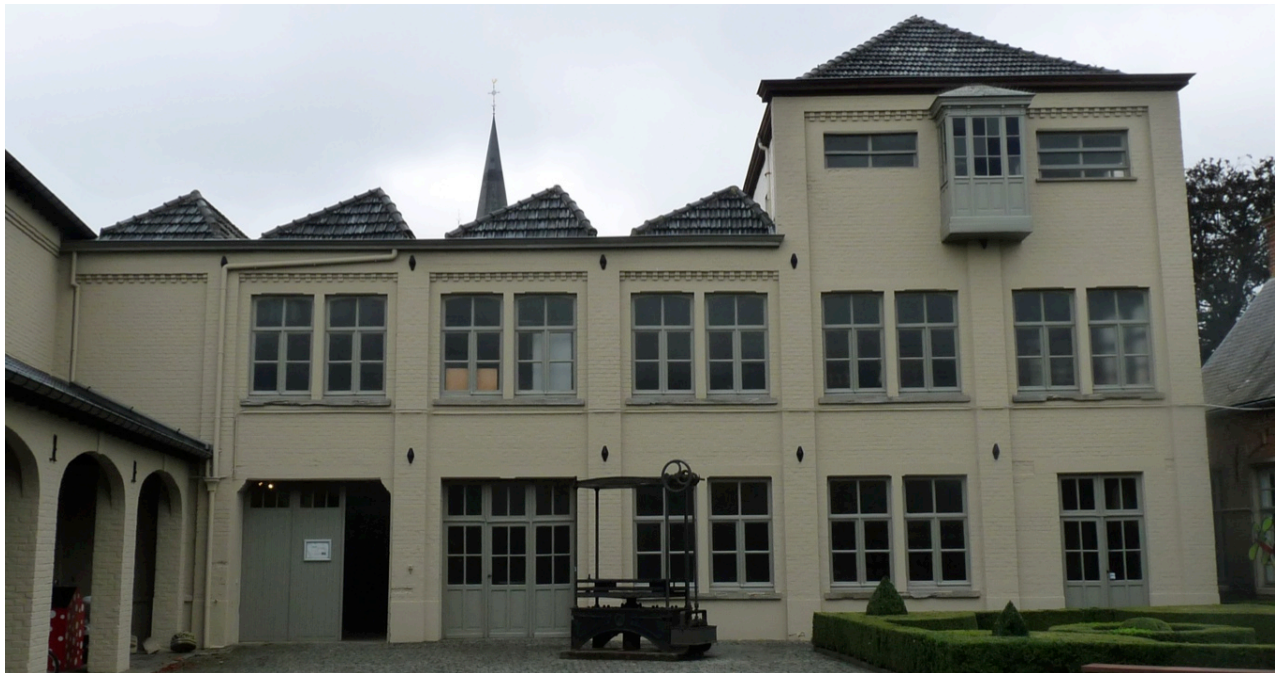
Figuur 6: zicht op oostgevel (gevel binnenkoer) van gebouw C.
